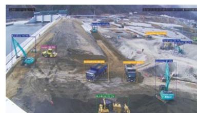
AIによるダンプおよび建機の識別
